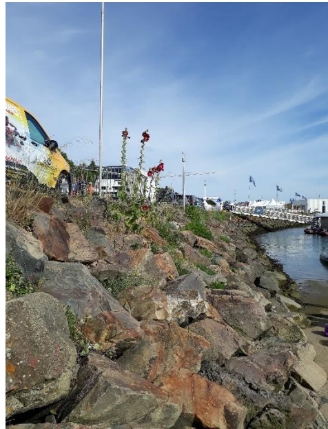
Figure 13 : Vue des enrochements
