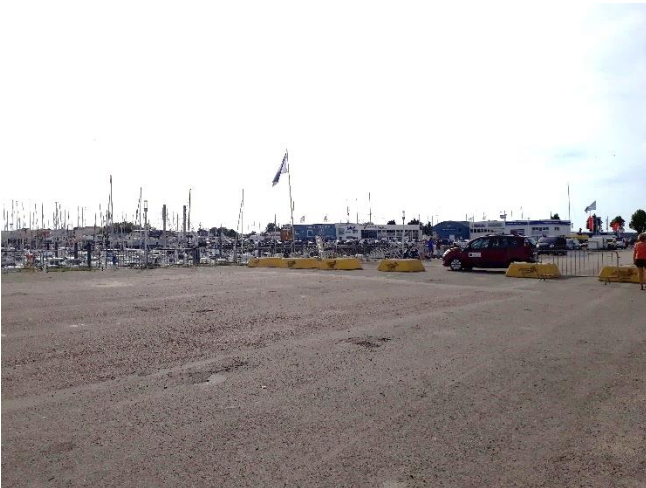
Figure 12 : Vue de l'esplanade bitumée
