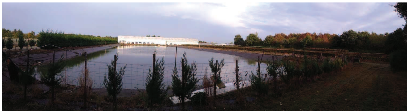
P5 - Photo du grand bassin existant situé sur la partie sud-est du site (prise de vue via la pointe Est du bassin 2)
