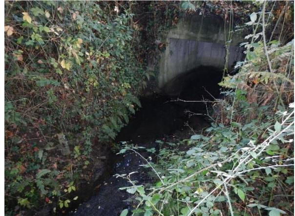
**Photo 2 : Dalot rejetant les eaux pluviales dans le cours d'eau temporaire**
