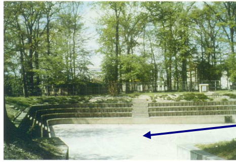
« bassin de rétention » double-fonction
