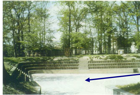
« bassin de rétention » double-fonction
