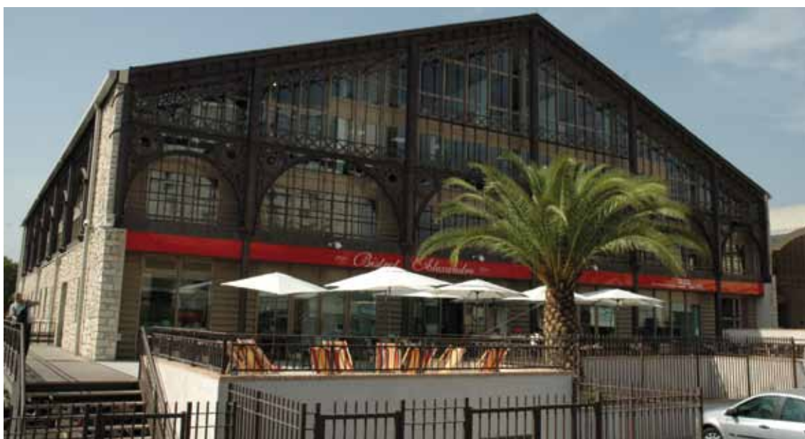
Centre d'affaire et d'équipements au cœur d'un quartier de logement social, la station Alexandre à Marseille
