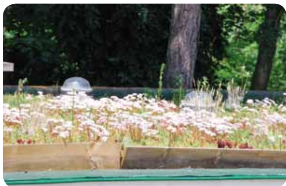
UN TOIT VÉGÉTALISÉ ABSORBE UNE PARTIE DES EAUX PLUVIALES
