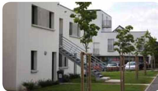
Immeuble Intermédiaire à Servon/Vilaine
