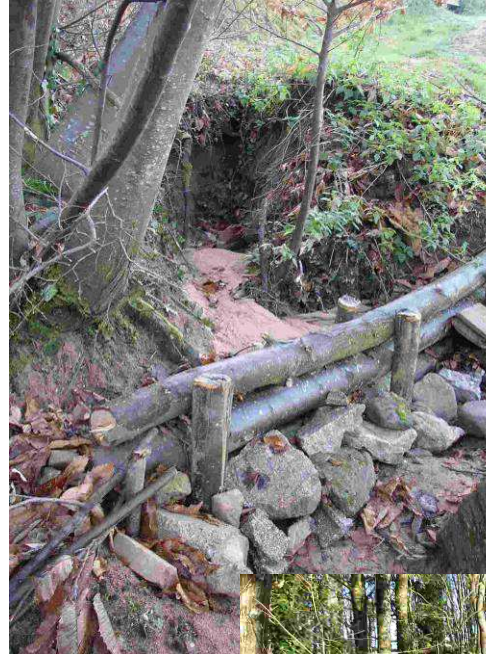
Aménagement de ravine destiné à dispenser un ruissellement concentré dans le Beaujolais ( Villié Morgon 69 )
