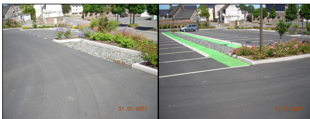
Photo 4 : Exemple de tranchées drainantes
