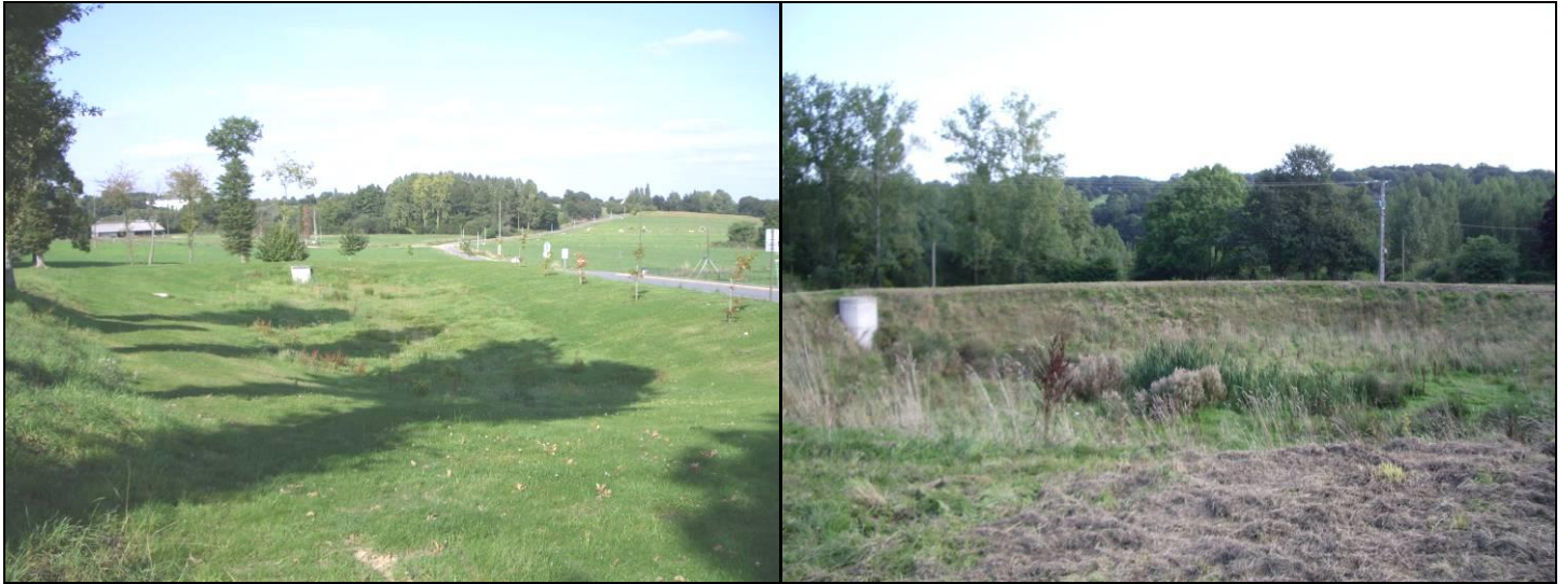
Photo 1 et 2 : Exemple de bassin tampon paysager à gauche (lot. des Chênes – commune de CAULNES) et non paysager à droite (lot. des peupliers – commune de CAULNES)
