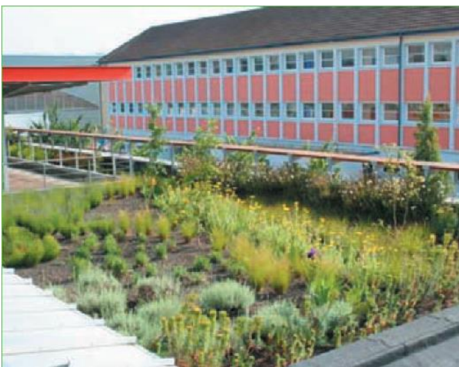
Toiture stockante végétalisée
