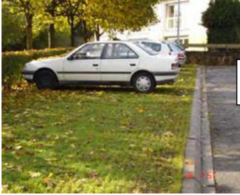
Parking engazonné perméable
