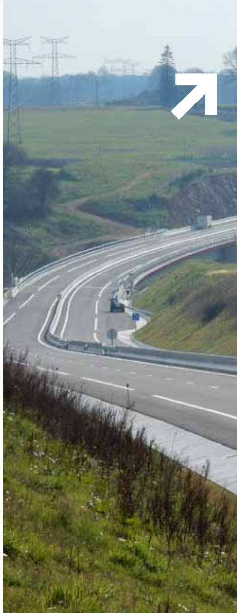
LA DÉVIATION SUD | DIR OUEST
