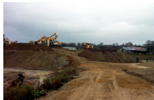
LES TERRASSEMENTS AU DROIT DU PETIT MESNIL | DIR OUEST
