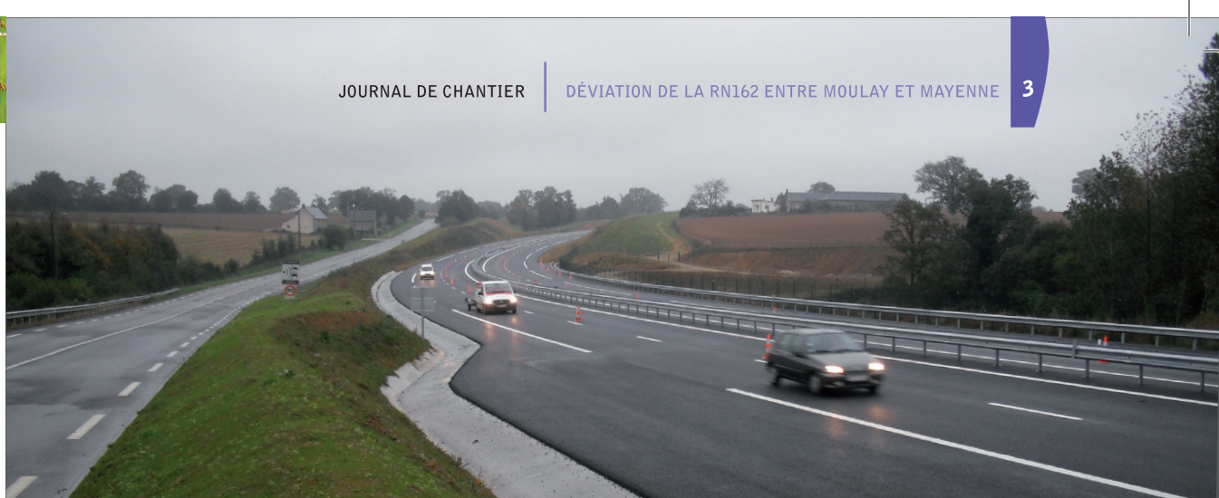
SECTION MISE EN SERVICE | DIR OUEST
