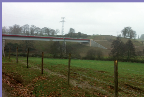
LE VIADUC SUR L'ARON | DIR OUEST
