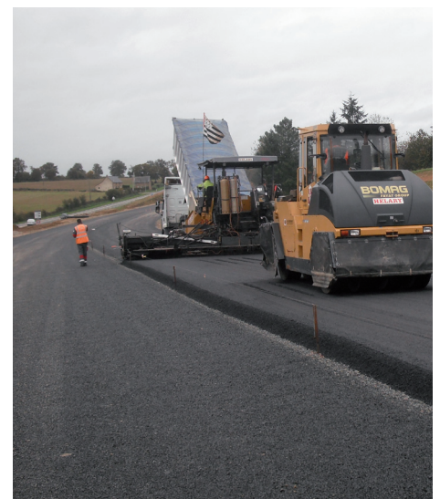
TRAVAUX D'ENROBÉ | DIRO
