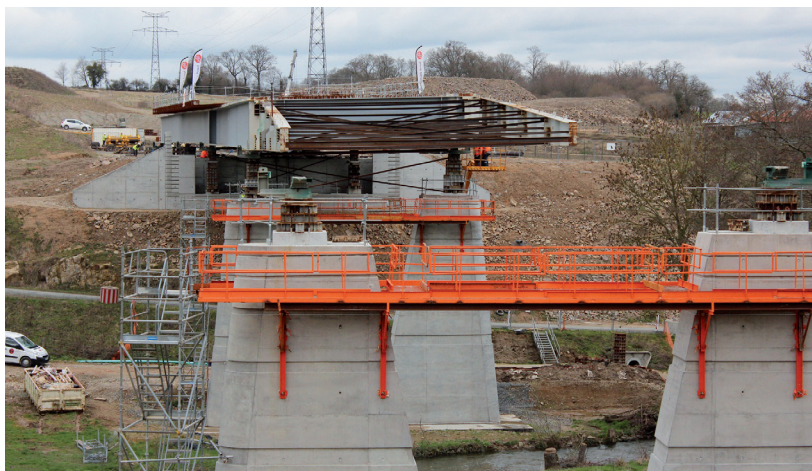
LE LANÇAGE DU VIADUC DU 18 AU 20 FÉVRIER 2014 | DIRO
