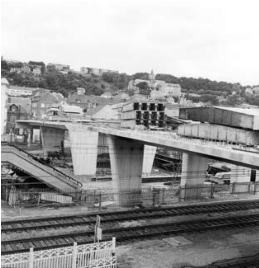
Le Havre, Pont Blanc, Fonds du Ministère de la reconstruction et de l'urbanisme (MRU) -1967© METL MEDDE
