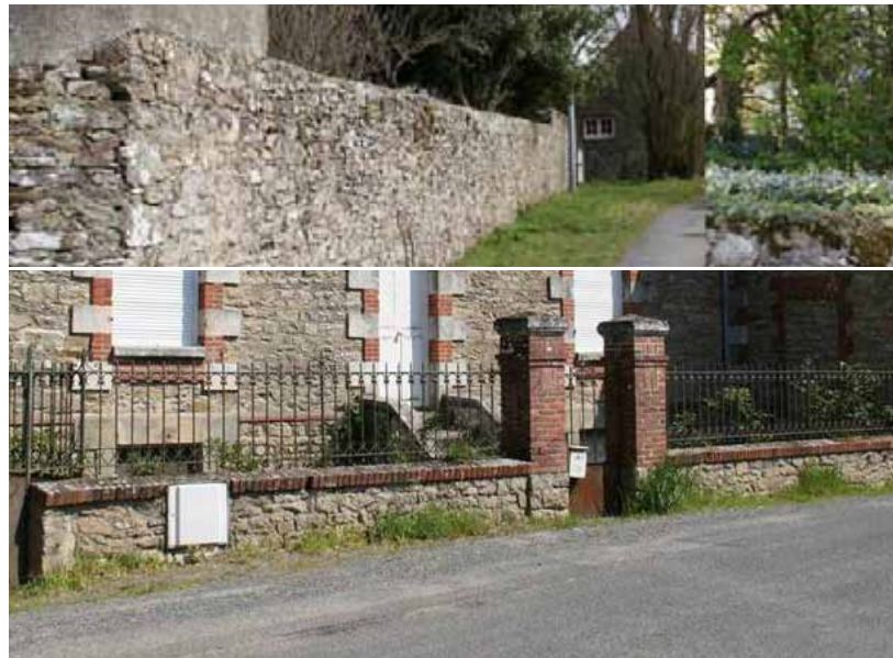
Mur et grille à conserver
