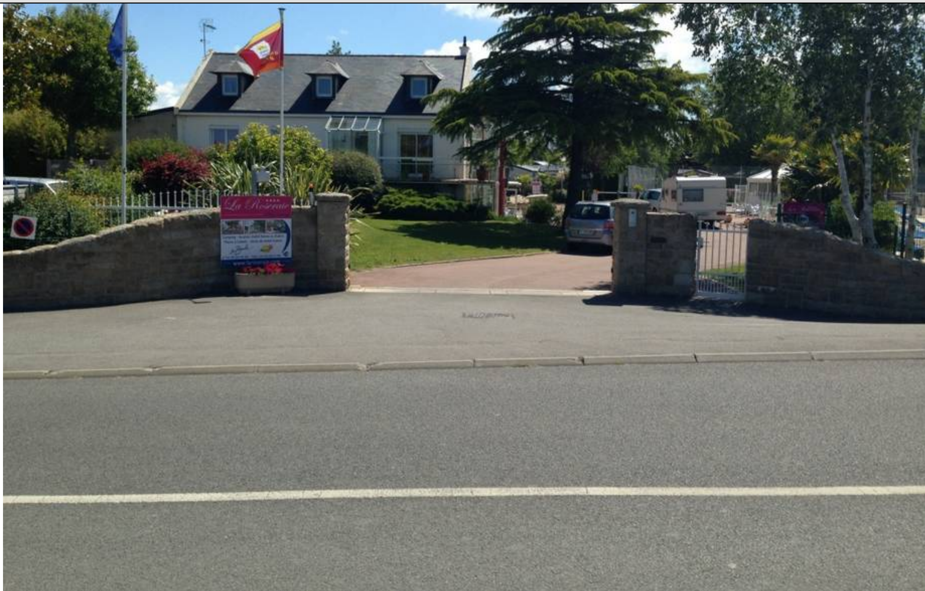
Photo n°5 : Vue de l'accès à l'établissement
