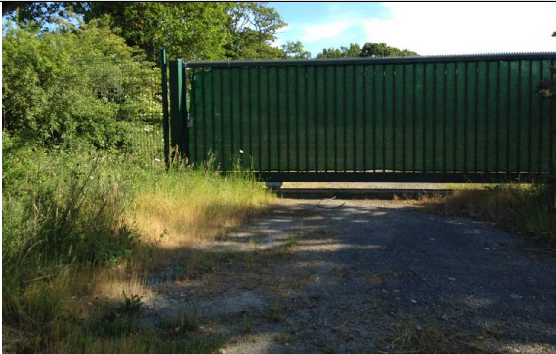
Photo n°4 : Issue de secours à l'ouest
