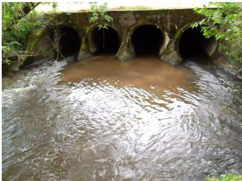
Photographie 9 : ouvrages de franchissement du Cens
