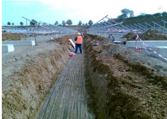
Centrale photovoltaïque en cours de réalisation.
