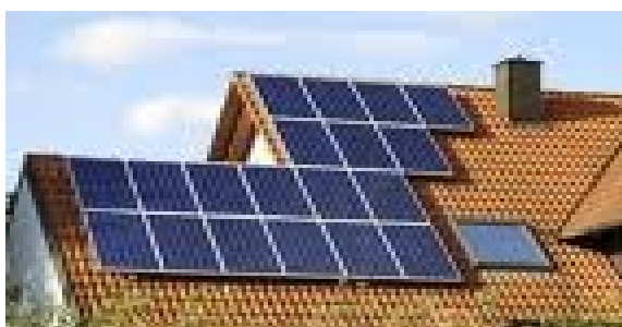
Installation photovoltaïque révélant une insuffisance de prise en compte des objectifs d'intégration architecturale
