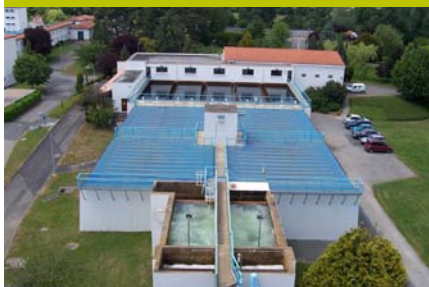
Station de traitement d'eau potable.
