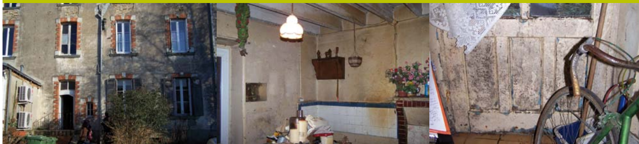
Réseaux d'eau non conformes d'un immeuble.
