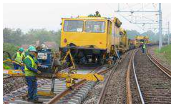
Longs Rails soudés sur traverses béton
