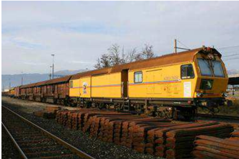
Train meuleur de rails (Scheuchzer S.A.)
