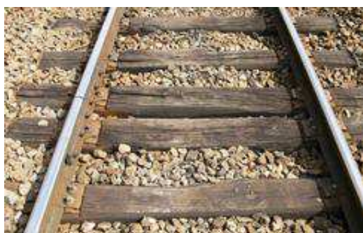
Rails courts sur traverses bois
