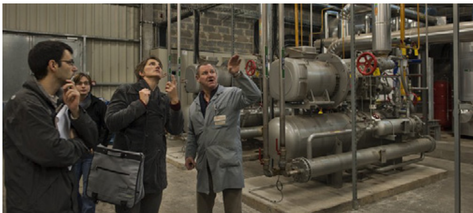
▲ Contrôle d'installations frigorifiques
