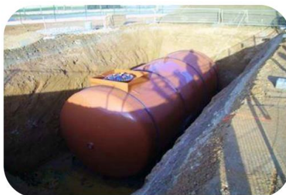
Figure n°65. CUVE DE FIOUL
