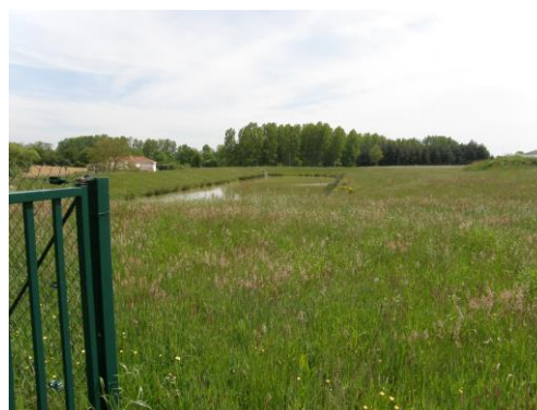
Figure n°80. BASSIN DE RETENTION DES EAUX PUVIALES
