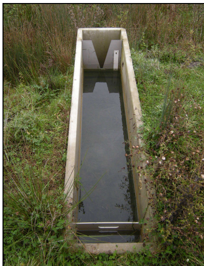
Vue du canal de comptage Sortie
