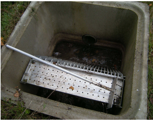
Vue du dégrilleur statique (entrée lagunage)
