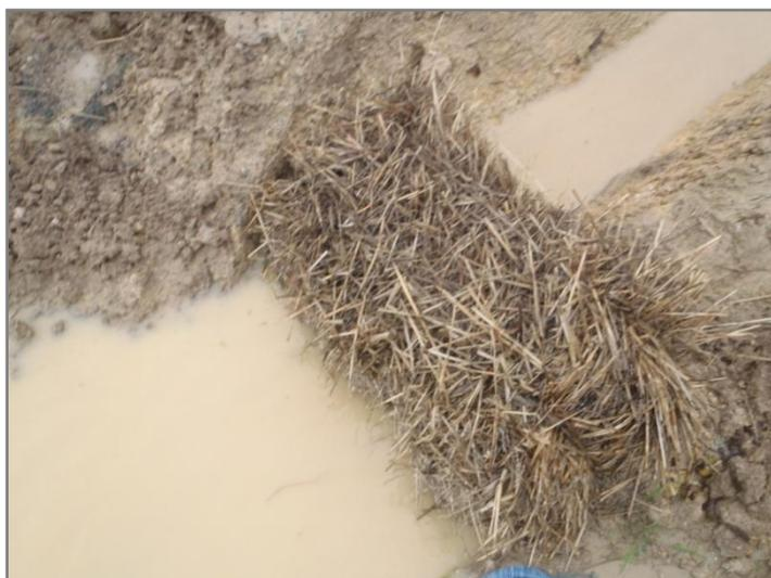
**Photo 20 : exemple de filtre à particule sur un fossé avant rejet au cours d'eau**
