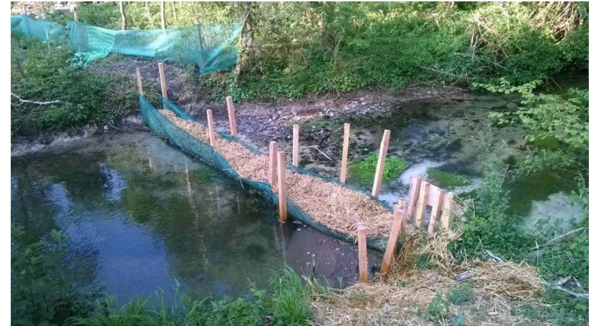
**Photographie 30 : Exemple de filtre à paille en phase chantier**
