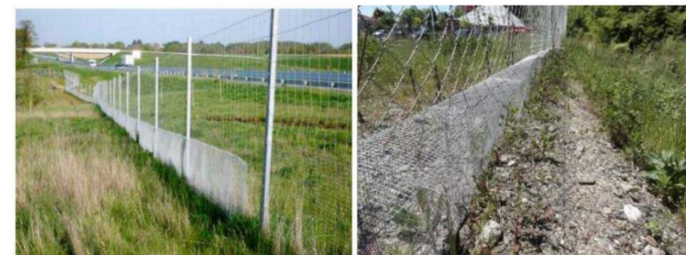
**Photographie 27 : Exemple de clôtures à maille progressive doublées d'une clôture basse à mailles fines 5 mm x 5 mm**
