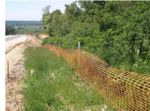
**Photographie 28 : Exemple de barrière de chantier**
