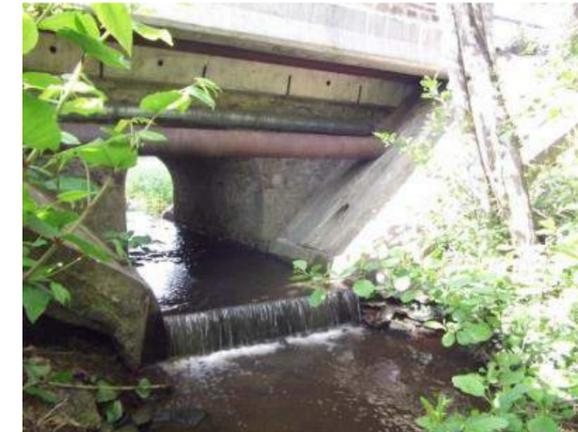
**Photographie 39 : Ouvrage non franchissable en raison d'une chute et d'un trop faible tirant d'eau**
