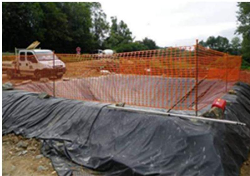
**Photographie 29 : Exemple de bassin de décantation étanche en phase chantier**
