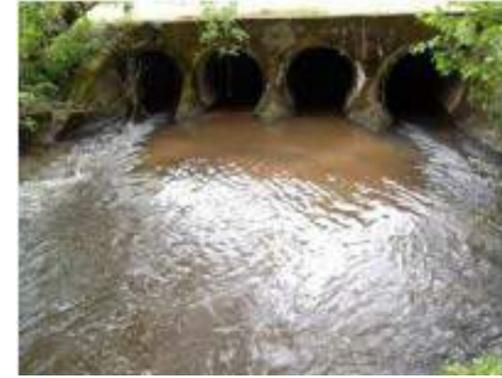
**Photographie 23 : buses hydrauliques rétablissant les écoulements du Cens**
