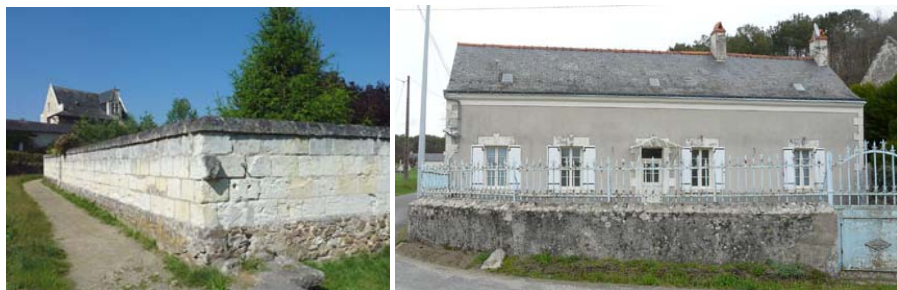
Exemples de murs de clôture à protéger
