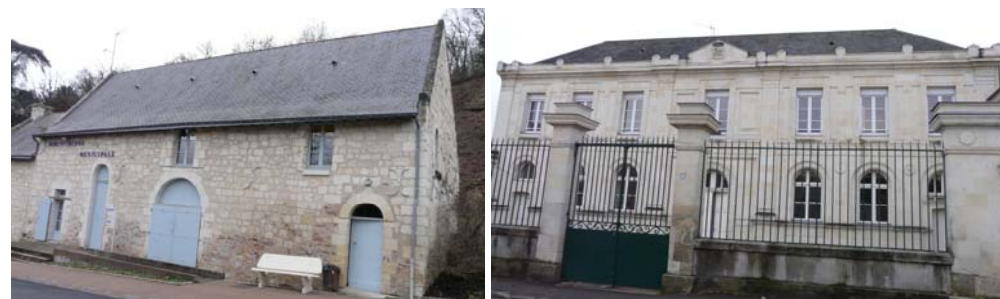
Exemples d'immeubles de la catégorie « patrimoine architectural remarquable »
