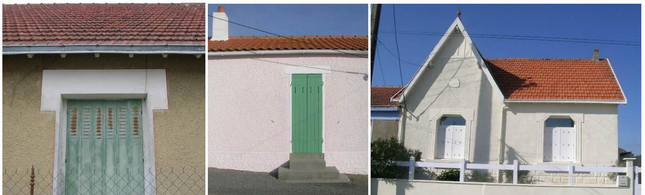
Le béton est utilisé aussi dans les décors (modénatures, balcons, linteaux et corniches dans les maisons Art-Déco, faux pan de bois en relief dans les constructions d'esprit néo-régionaliste).
