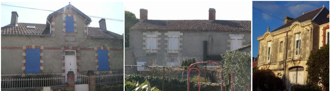
La maçonnerie traditionnelle en moellons de pierre locale, exigeant une mise en œuvre et un savoir-faire spécifique, est progressivement remplacée par des matériaux industriels tels la brique et le **parpaing ciment ou mâchefer**, recouverts d'un enduit ou d'un parement décoratif.
