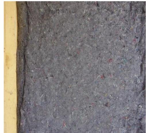
*Isolation intérieure en fibre de textiles recyclés (Métisse)*
