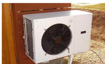
La pompe à chaleur air/eau qui alimente le plancher chauffant basse température est de marque HSC et de puissance 4 kW.
