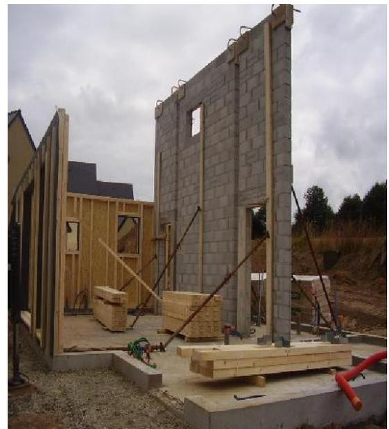
*Mur masse en béton*
