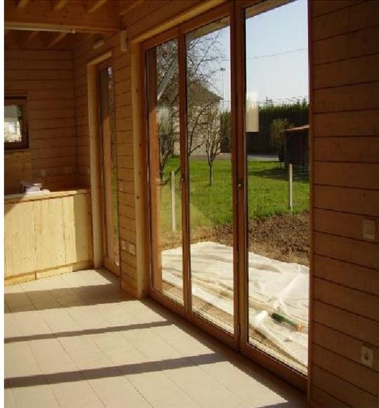
Les menuiseries retenues sont du double vitrage 4/16/4, habillage bois à l'intérieur et aluminium à l'extérieur :  $U_w=1,8 \text{ W/m}^2.K$
