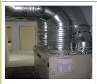
La ventilation retenue a été une VMC double-flux type Gold à haut rendement avec échangeur de chaleur.
