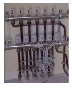
Des compteurs sur l'énergie, l'eau froide et l'eau chaude sanitaire ont été installés pour permettre la visualisation des consommations. De plus, la régulation du chauffage a été prévue par simulation en fonction de l'usage et des apports passifs, avec zonage pièce par pièce.
