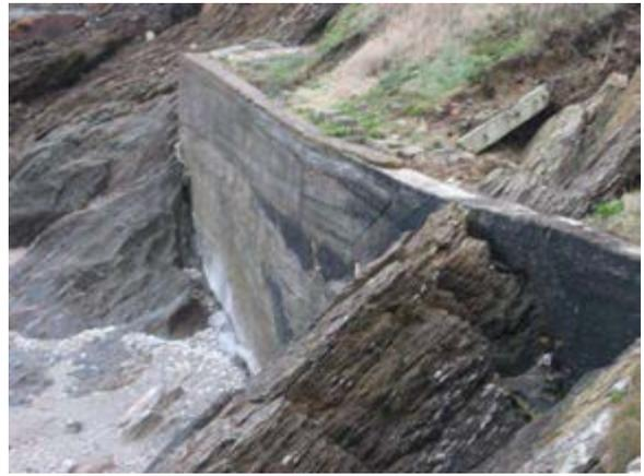
Entre Port au Loup et Port Kennet, perré bétonné maintenant glissement
