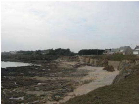
Baie du Manneric, plusieurs ouvrages de protection de la falaise (perré en enrochements, murs verticaux)
