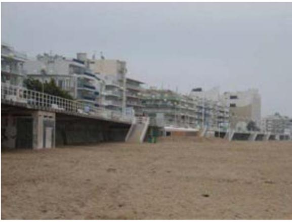
Promenade avancée par rapport au perré, surplombant la plage, puis perré maçonné vertical en haut de plage Rampe d'accès
