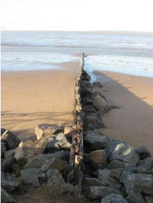
Epi en bois renforcé côté Nord par quelques enrochements
