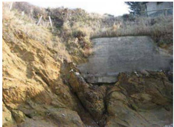
Falaises d'arrière plage en érosion avec maintien par des ouvrages de confortements (ici mur bétonné et grillage)
