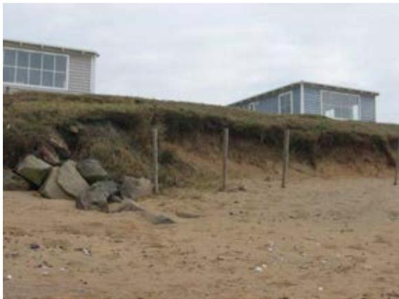
Port Levène: érosion du cordon dunaire et protection par des perrés en enrochements de haut de plage
