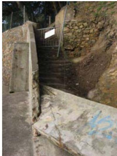
Portion de sentier inaccessible et protégé par barrière car érosion de la falaise en-dessous
