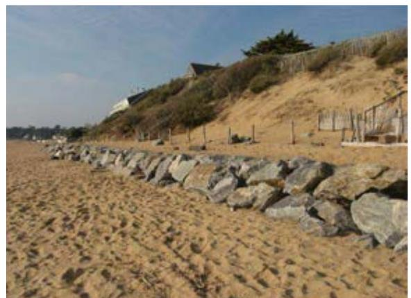
Côté de la pointe de la Lande, cordon dunaire protégé en pied par des ganivelles ou une barrière puis par une perré en enrochements séparant un accès piétonnier
