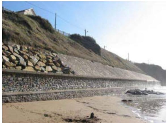
Perré maçonné de maintien de la falaise d'arrière plage
