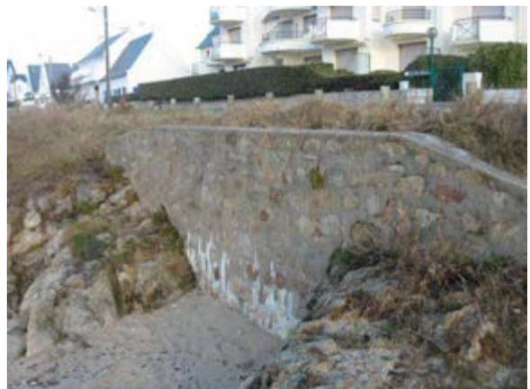
Les ouvrages de confortement: (1) perré en enrochements avec rampe à gauche, (2) perré maçonné à droite (Baie du Crucifix)
