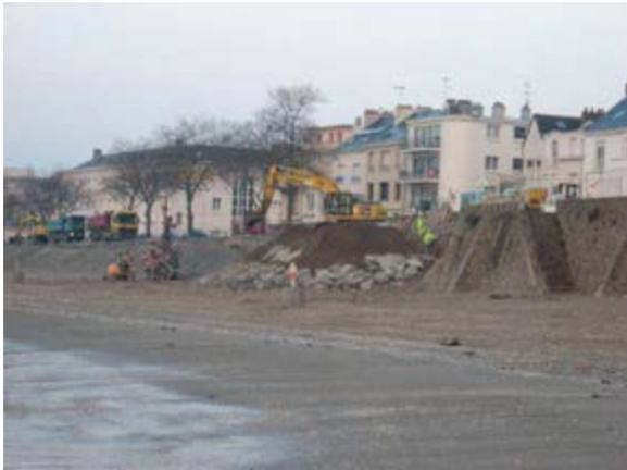
Construction d'un perré d'arrière plage en enrochements
