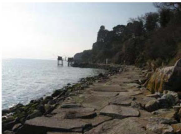
Sentier littoral en enrochements mais interdit à la circulation et bloqué car risques d'éboulements
