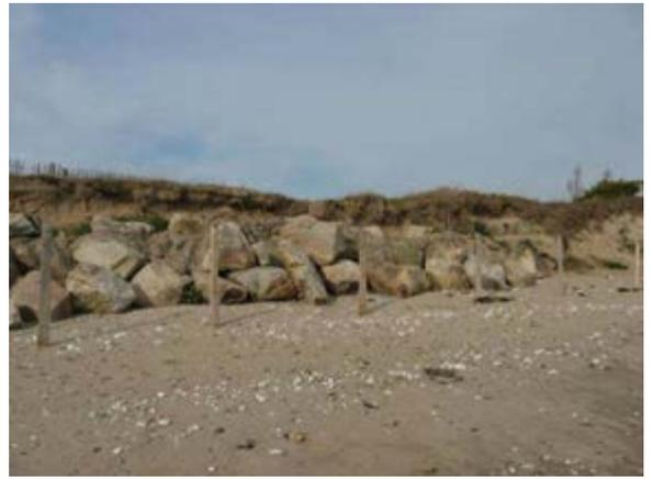
Cordon dunaire en érosion, protégé par un perré en enrochements
