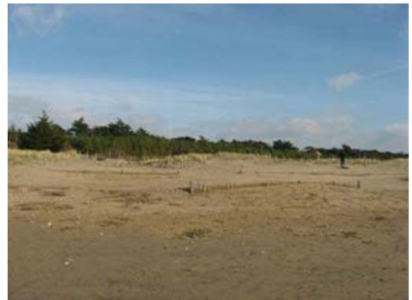
Ganivelles devant les chemins d'accès pour limiter les siffle-vents
