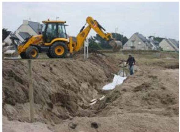
Plage du Grand Lanroué, enrochements et falaises d'érosion derrière, et construction d'un nouveau perré en enrochements
