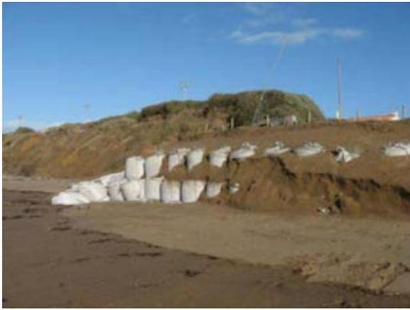
Maintien du cordon par des sacs géotextiles remplis de sable
