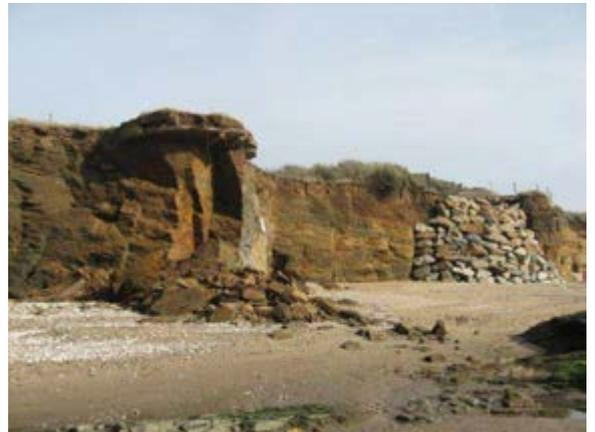
Falaises d'arrière plage de la pointe du Bile confortées par des enrochements
