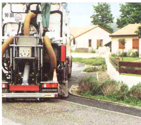
Machine de décolmatage. Source Cete du Sud-Ouest.
