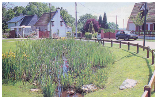
Noue engazonnée Opération Belbeuf – 76 Source Foncier Conseil
