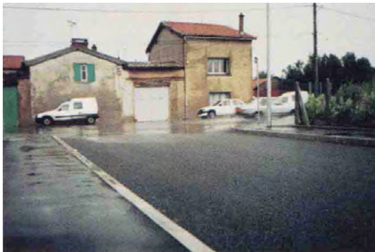
Contraste entre une chaussée classique et une chaussée drainante Source INSA de Lyon
