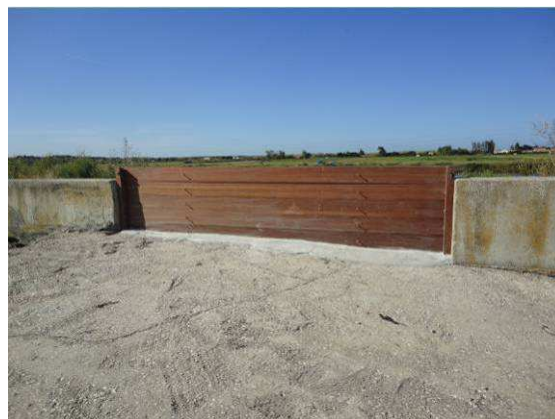
Cale de la Tresson : mise en place de batardeaux/bastaings en bois
