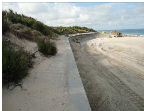
Perré des Sénégalais après travaux
