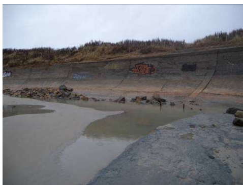
Perré des Sénégalais avant travaux
