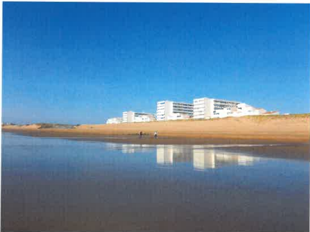
Photo 2 - Vue au sud du site
