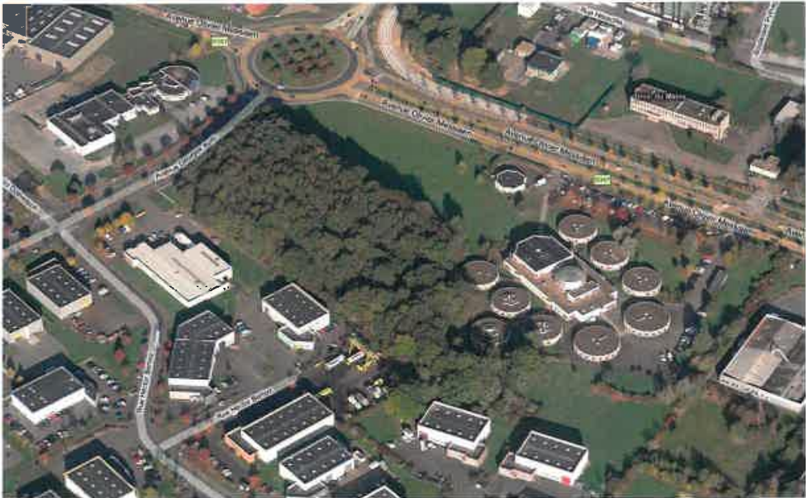
Vue depuis le sud-est
