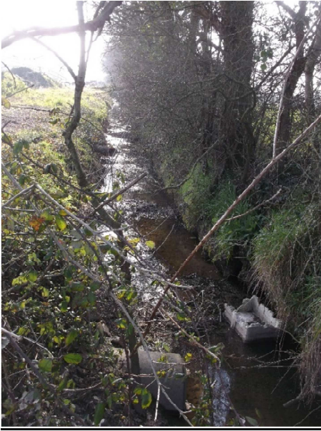
Fossé parcelle C 1554 côté Ouest du projet
