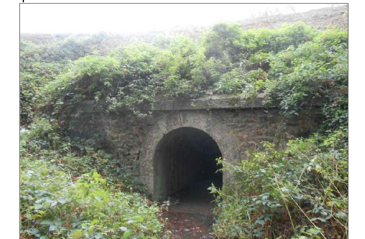
photo 4 - OH vue aval
