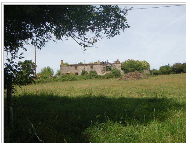
Ancienne maison en ruine.
