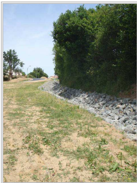
Fossé avec enrochement.
