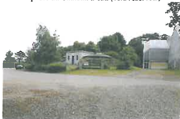
Arrivée sur le réservoir bas de St Nicolas de Redon
