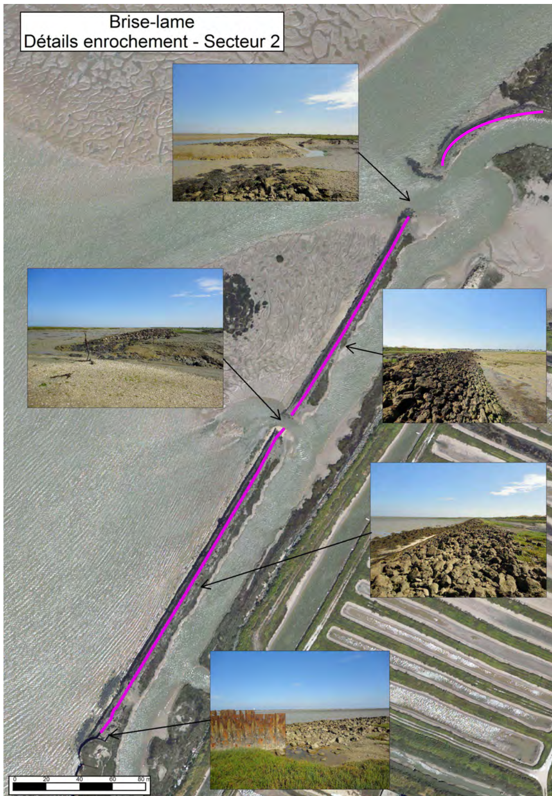
Figure 16 : Secteur 2 – détail du tronçon
