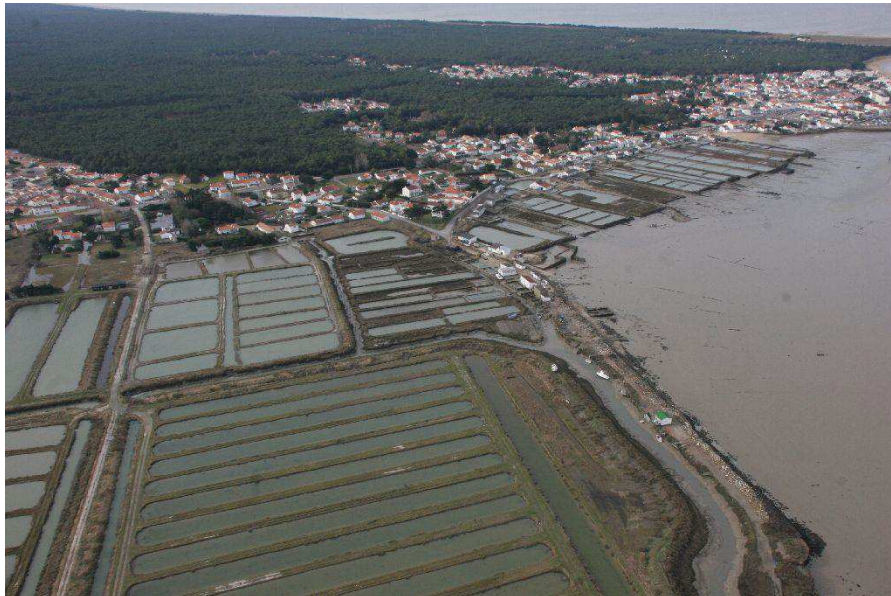
Figure 5 : La Barre de Monts – photo DREAL – après le passage de Xynthia – secteur du brise lame
