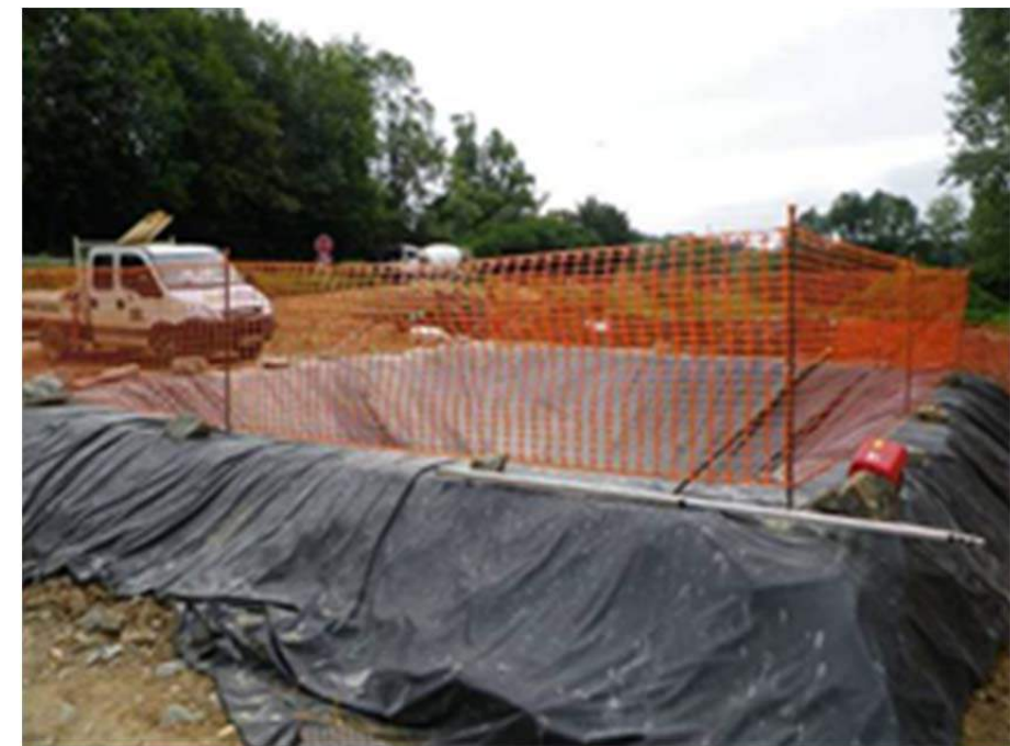
Figure 191 : Exemple de bassin de décantation étanche en phase chantier
