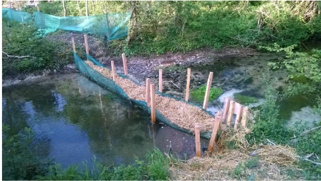
Figure 192 : Exemple de filtre à paille en phase chantier
