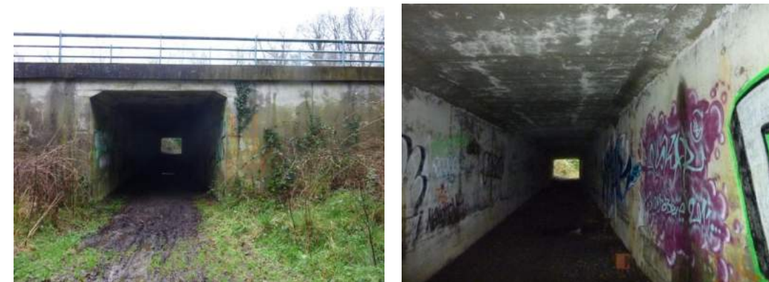
Figure 45 : Ouvrage de la Bigeottière
