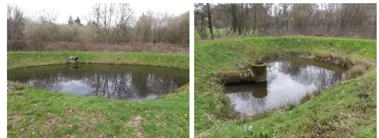
Figure 21 : Bassin de traitement n°3a
