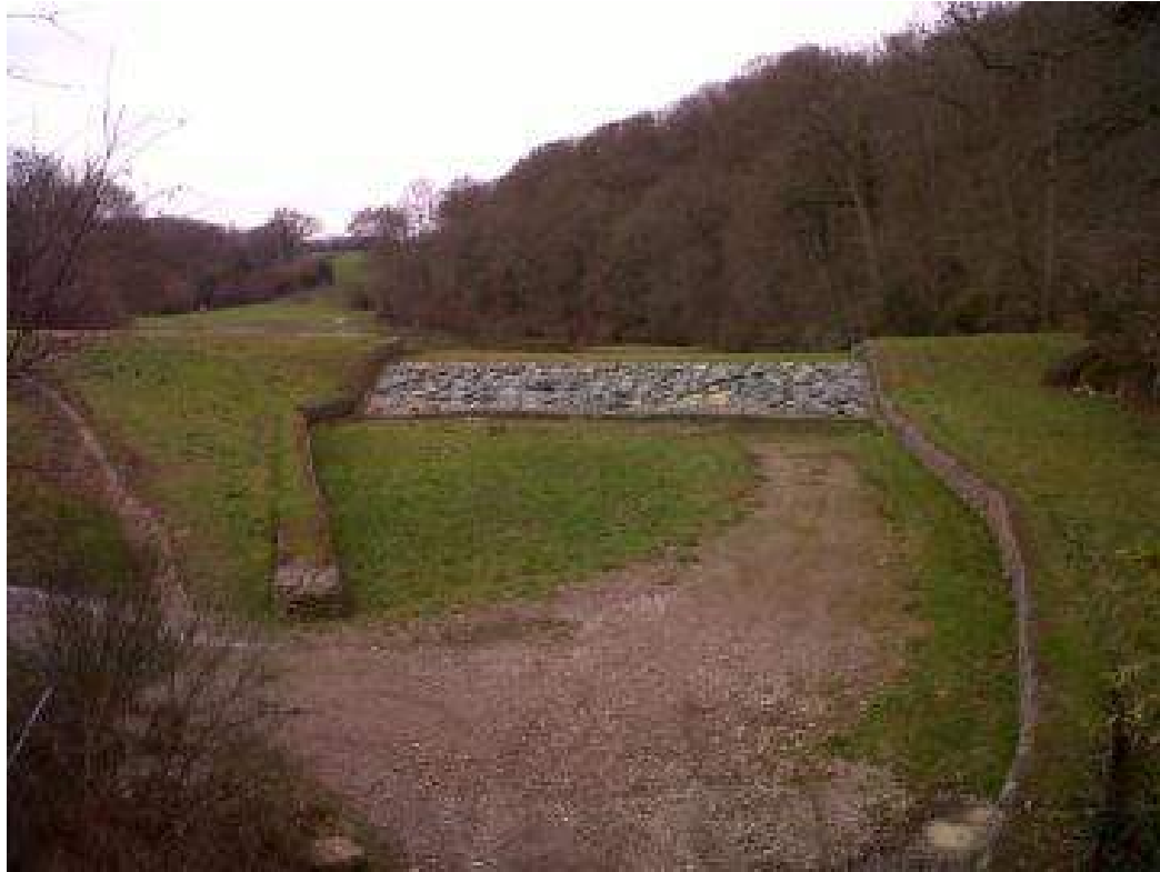
Figure 14 : Vue aval de la digue et de son déversoir
