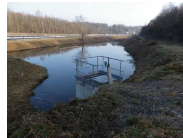
Figure 17 : Bassin de traitement n°1
