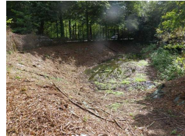
Figure 19 : Bassin de traitement n°2 de la Jallière
