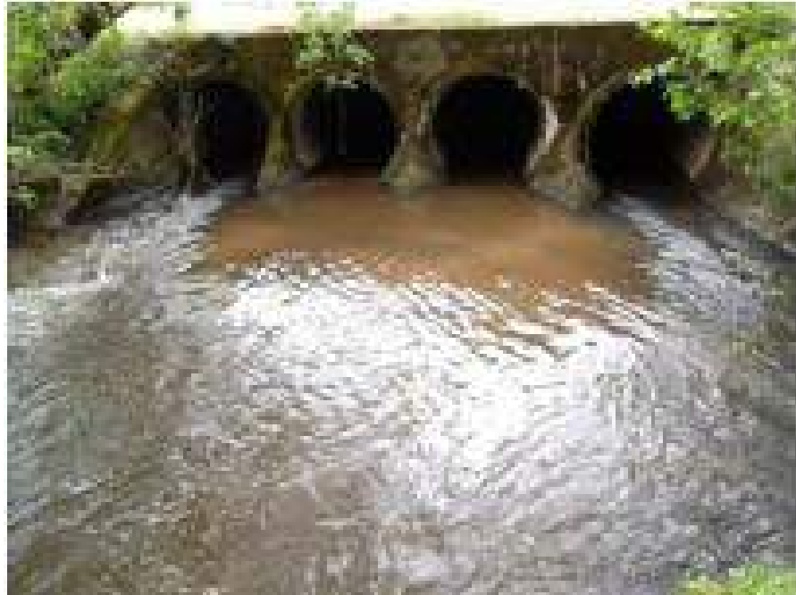
Figure 55 : buses hydrauliques rétablissant les écoulements du Cens
