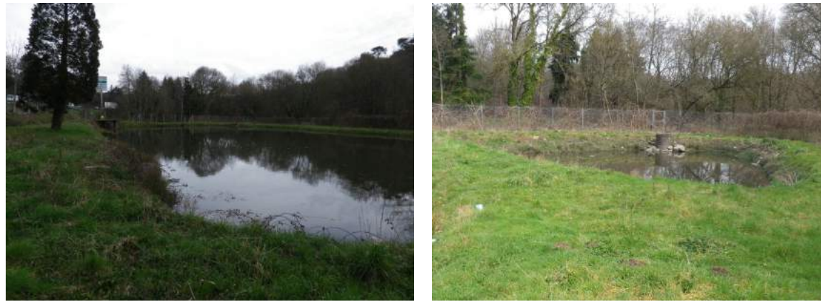
Figure 22 : Bassin de traitement n°3b
