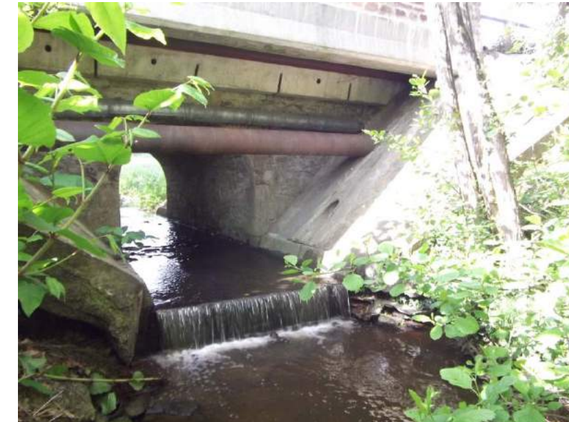
Ouvrage non franchissable en raison d'une chute et d'un trop faible tirant d'eau
