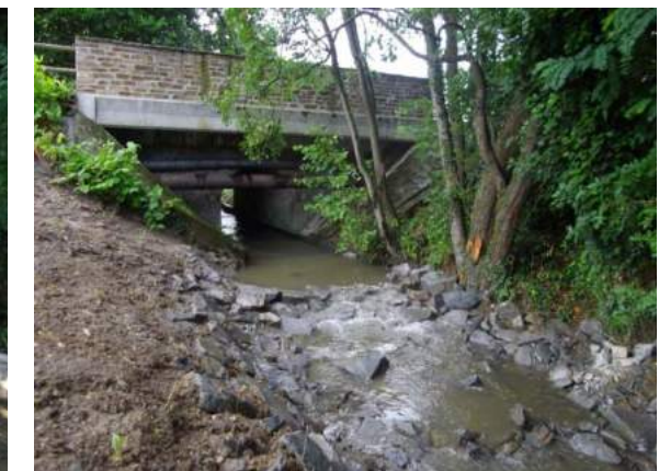
Après travaux, ligne d'eau rehaussée L'ouvrage est franchissable par les poissons
