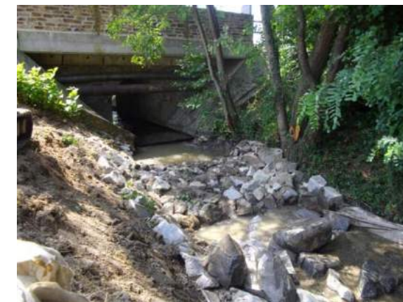
Pendant les travaux : géotextile et enrochements
