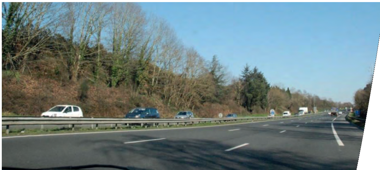
Périphérique nord - sens porte d'Orvault / porte de Rennes
