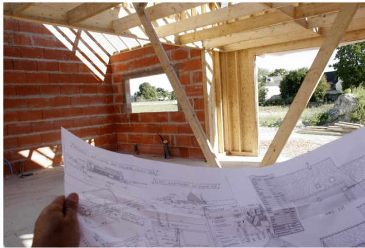
Chantier de construction d'un lotissement en 2007 (Pays de Loire) Roland BOURGUET / ADEME
