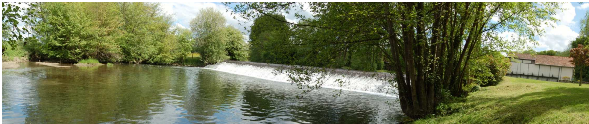
Photo 4 – Vue aval, seuil déversoir en rive droite et île du propriétaire (en arrière-plan, la centrale)
