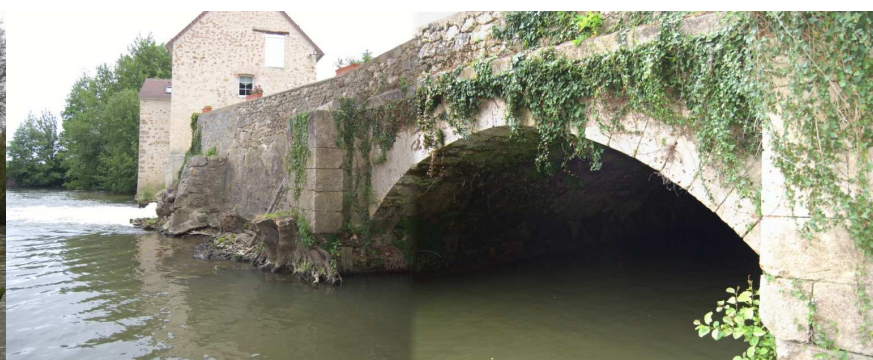
Photo 6 – Tunnel de fuite de l'ancienne centrale
