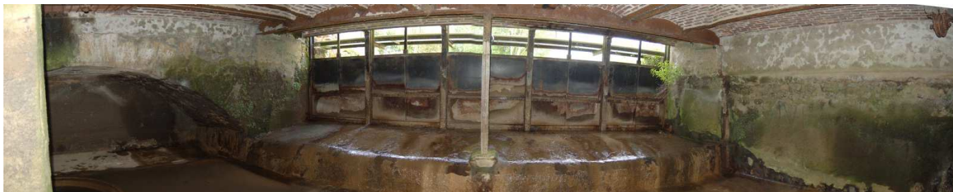
Photos 3 – Chambre d'eau de l'ancienne centrale hydroélectrique
