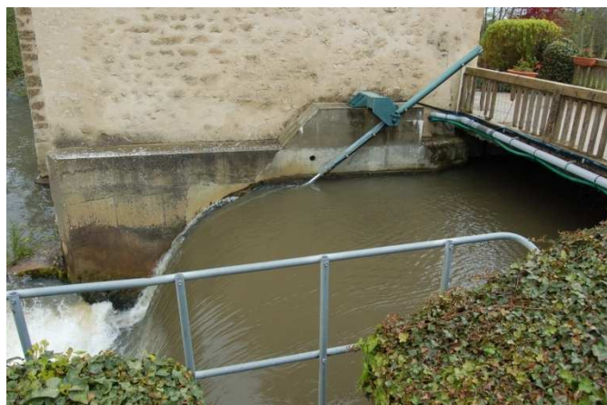
Photo 7 – Clapet de régulation appartenant au Syndicat Mixte de la Rivière Huisne
