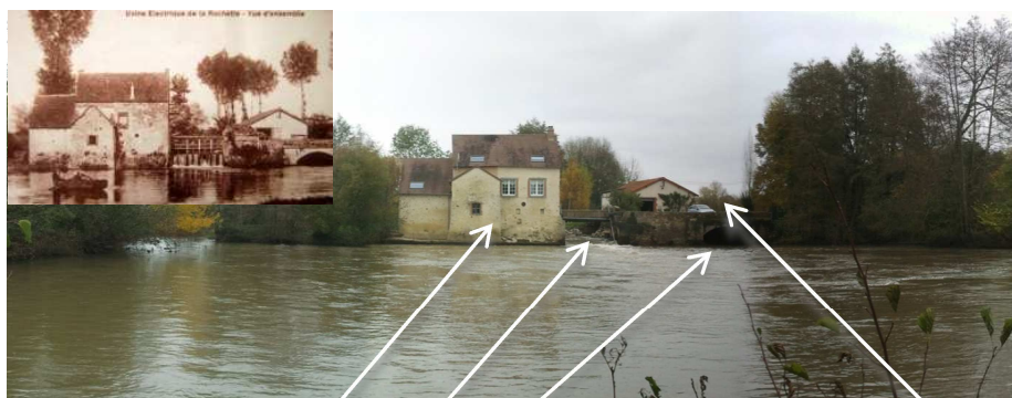
Photo 5 – Vue aval - Moulin, clapet, tunnel de fuite et ancienne centrale
