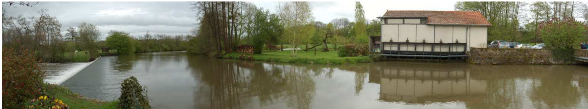
Photo 1 – L'ancienne centrale hydroélectrique (avec 5 vannes dans la passe usinière) et le seuil déversoir en rive droite – Vue amont
