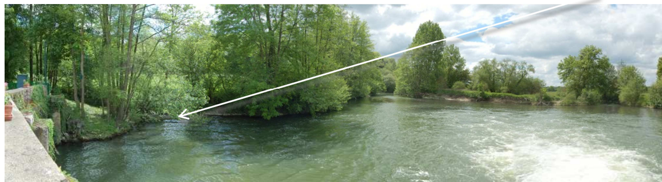
Photo 8 – Vue sur l'aval et la jonction avec le bras de décharge
