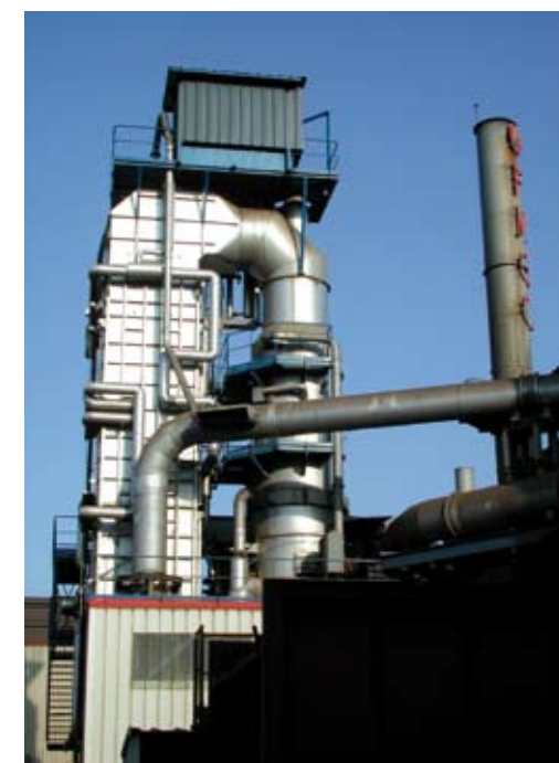
Fonderie FMGC à Soudan (44) - Dépoussiérage des gaz de cubilot.
