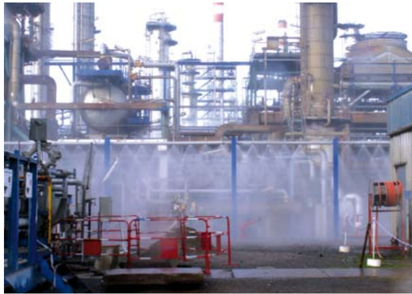
Société Total France à Donges (44). Test des rideaux d'eau protégeant le poste de dépotage de l'acide fluorhydrique.
