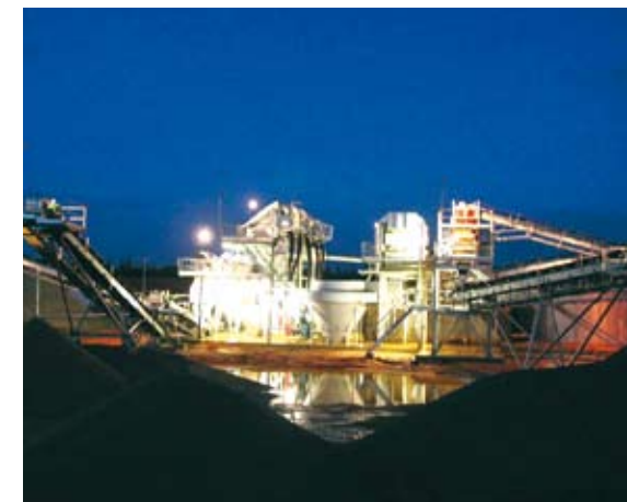
Installations de traitement vues de nuit (source UNICEM Pays de la Loire).
