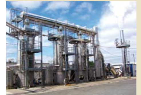
Société SNAM Antipol à Fontenay-le-Comte (85). Unité d'évapo-concentration de déchets industriels liquides.
