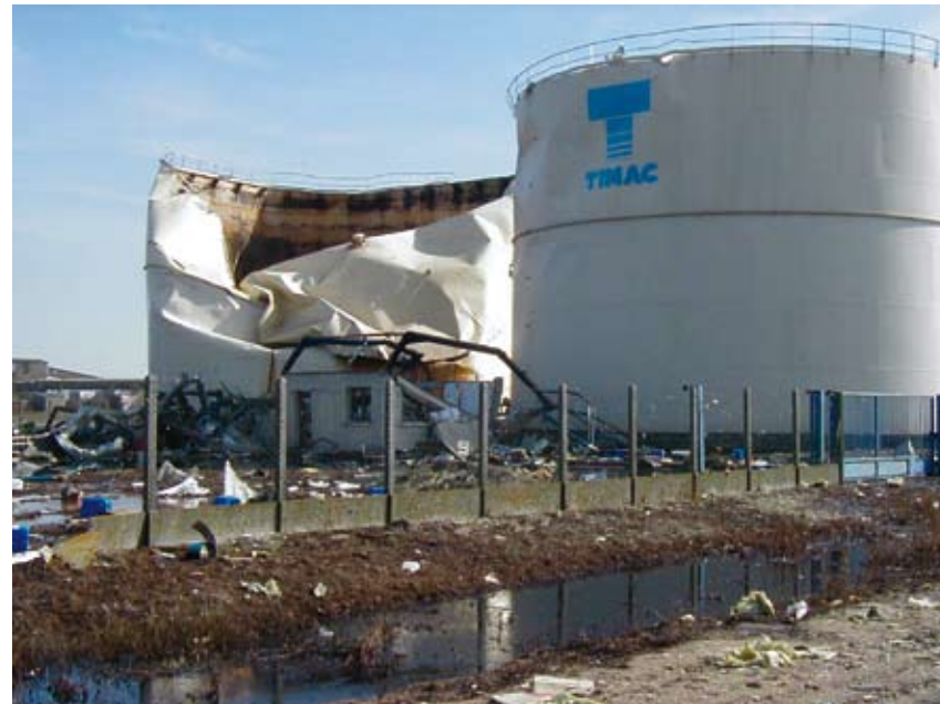
Accident TIMAC (Montoir-de-Bretagne), 2002.
