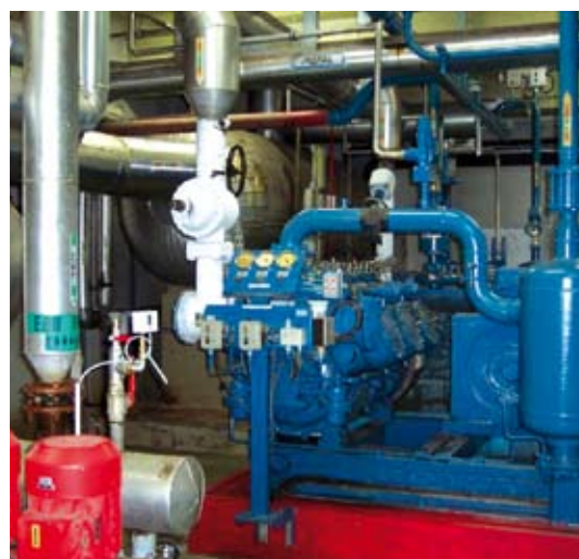
Abattoir de Châteaubriant (44). Compresseurs de réfrigération à l'ammoniac.
