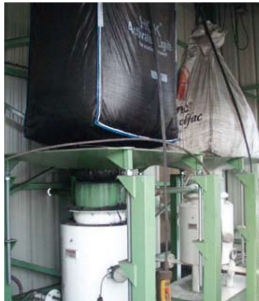
Fonderie GMBA à Ancenis (44) : cette importante fonderie de fonte a achevé en avril 2007 les travaux de mise en place d'un traitement spécifique des dioxines. Placé en amont du dépoussiéreur à manches existant, un dispositif d'injection de coke de lignite permet désormais de piéger par adsorption ces composés et d'en limiter strictement les émissions à l'atmosphère.
