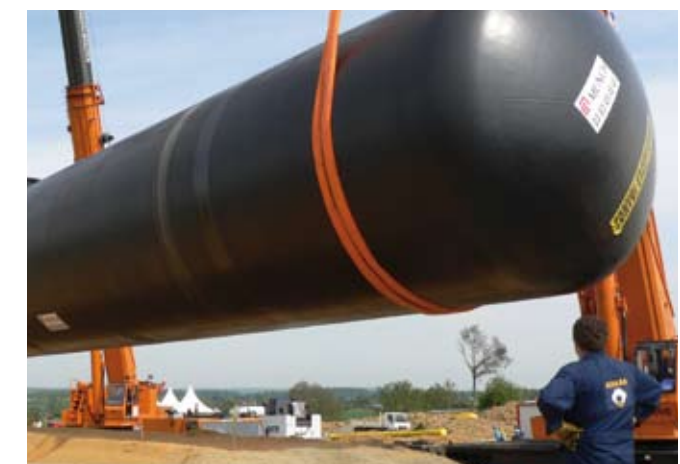
Sicogaz à Brûlon (72) - Positionnement du nouveau réservoir.
