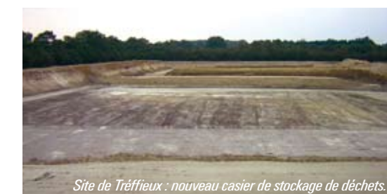
Site de Treffieux : nouveau casier de stockage de déchets.
