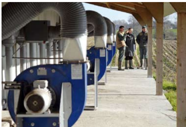
Système de ventilation des tunnels de compostage.
