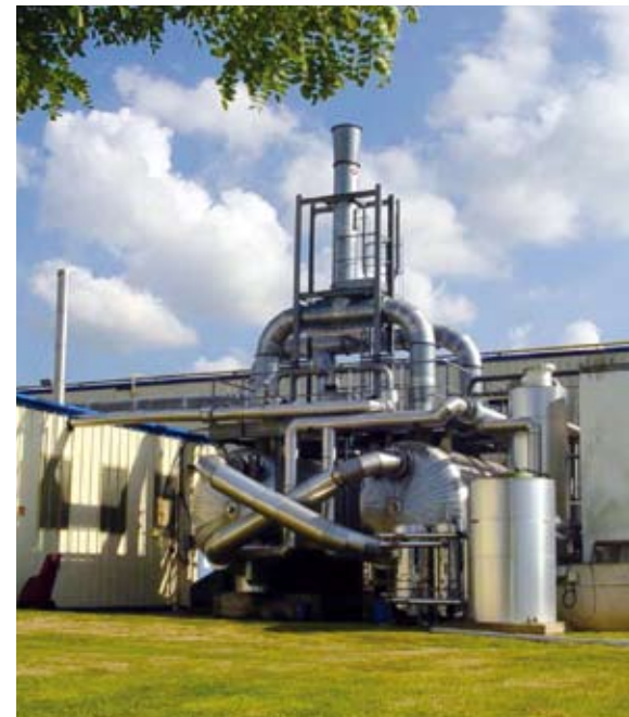
Radiateurs Industrie à La Chartre-sur-le-Loir : installation de récupération sur charbon actif des émissions de trichloroéthylène.
