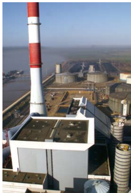
Centrale thermique EDF de Cordemais (44) - Unité de désulfuration des gaz des tranches charbon.
