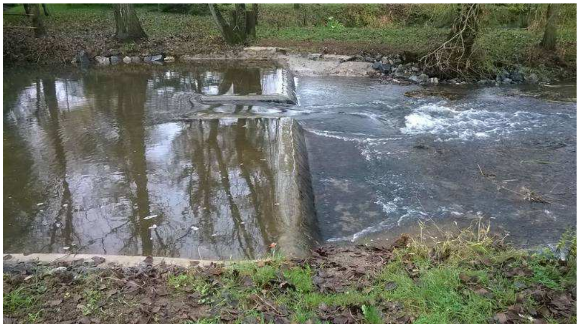
Station hydrométrique de la Smagne à Sainte-Pexine (85) : seuil reconstruit (18/11/2015)
