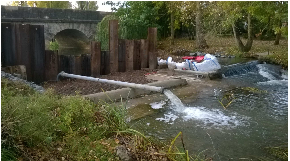
Réfection seuil jaugeur de la Smagne à Ste Pexine (85) – 21/10/2015
