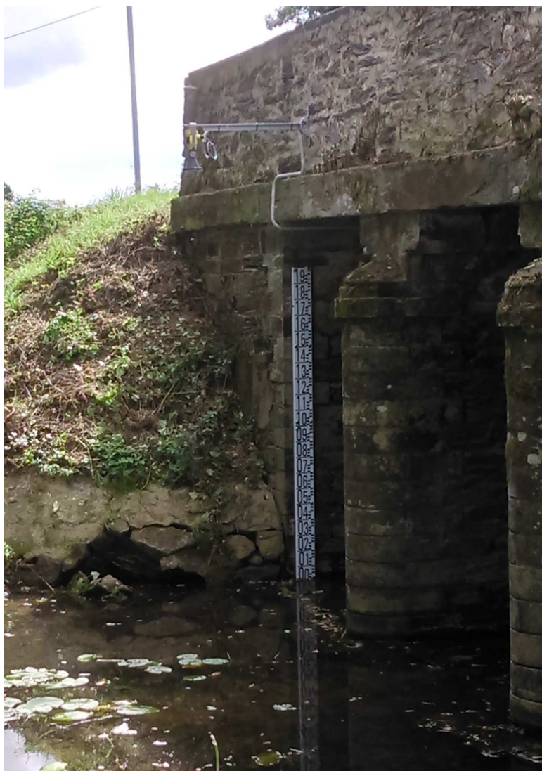
Nouvelle station d'hydrométrie installée le 04/09/2015 sur l'Isac à Saffré (44).
