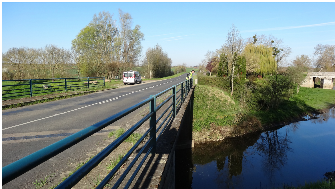
Tournée de contrôle sur station à Saint Georges sur Layon (49), avril 2016
