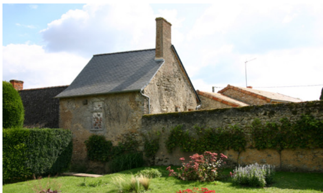
La pente de cette toiture en ardoise est adoucie par la brisure du coyau (changement de la pente en bas de toiture).
