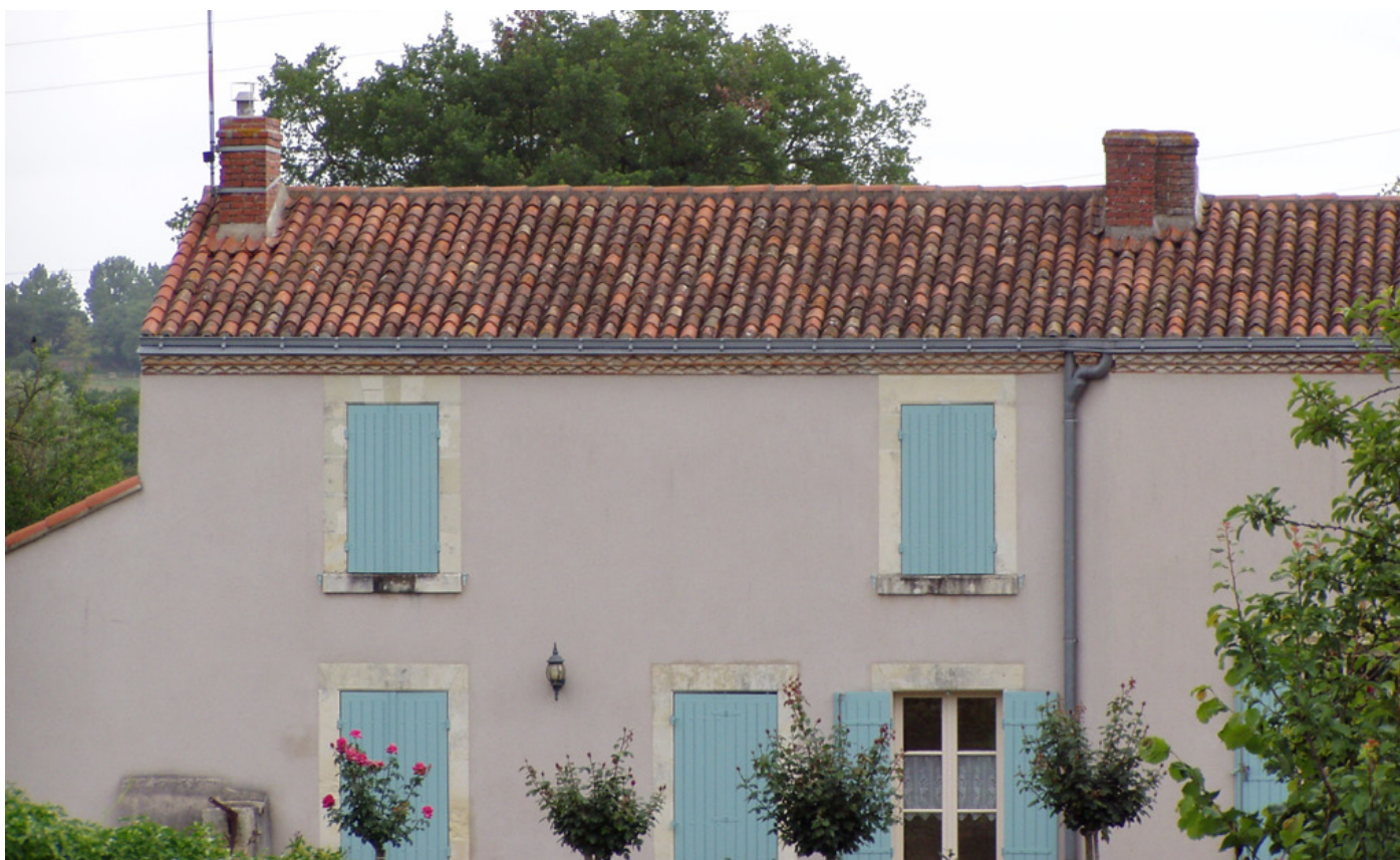
Exemple de maison de bourg dont la rive de toiture est traitée avec une génoise brique. Les nuances de la couverture en tuiles assurent un effet visuel intéressant qu'il est important de rechercher lors de la réalisation d'une toiture neuve.
