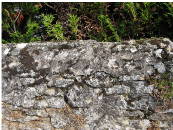
Le couronnement du mur est habituellement protégé par un glacis afin d'éviter les infiltrations d'eau dans la maçonnerie.
