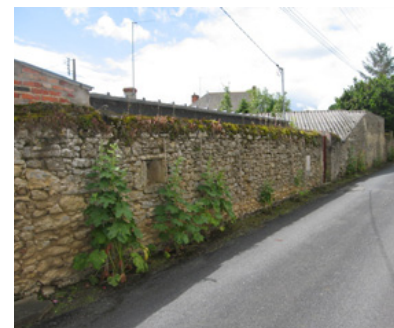
Murs rue Hoche
