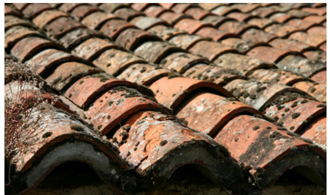
Exemple de couverture en tuile canal
