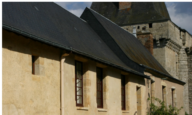
Façade du logis du Château. La teinte d'enduit est en accord avec la pierre locale.
