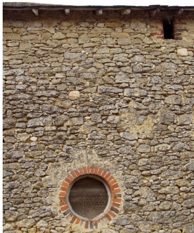
Exemple de façade appareillée en moellons.
