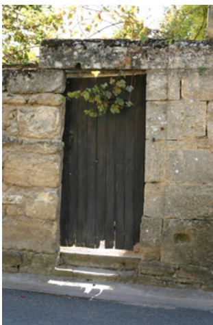
Le couronnement du mur est habituellement protégé par un glacis afin d'éviter les infiltrations d'eau dans la maçonnerie.
