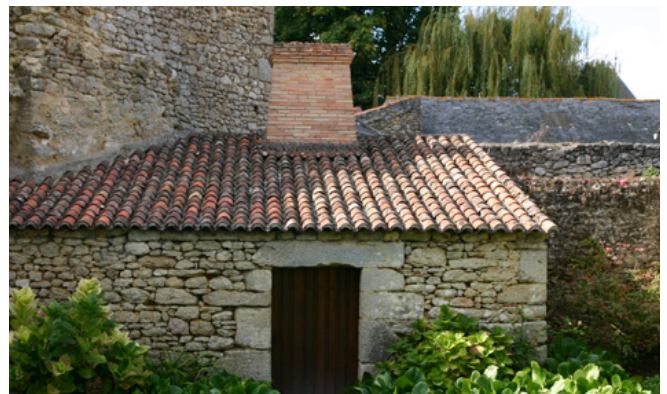
Exemples de couverture en tuile canal sur façade en moellons
